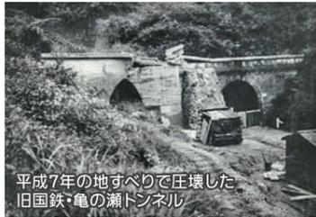
平成7年の地すべりで圧壊した旧国鉄・亀の瀬トンネル
